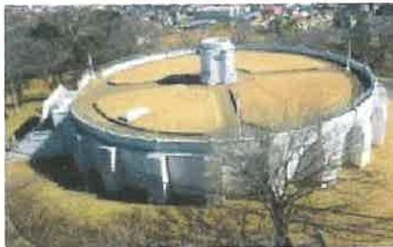
千葉分場1号配水池 (千葉市)
