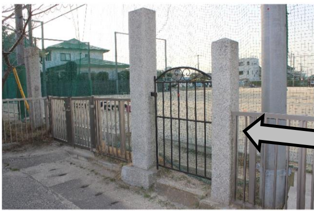
現在の「旧門柱」（昔の「正門」）
